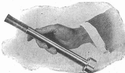
Schraubenbolzen von 22 mm Durchmesser, 65 mm Länge des Gewindes, 205 mm ganze Länge, aus dem vollen Stabe von 44 mm Durchmesser geschnitten und komplett fertig gemacht, inbegriffen das Richten und das Abfassen des Kopfes in 6 Minuten.
