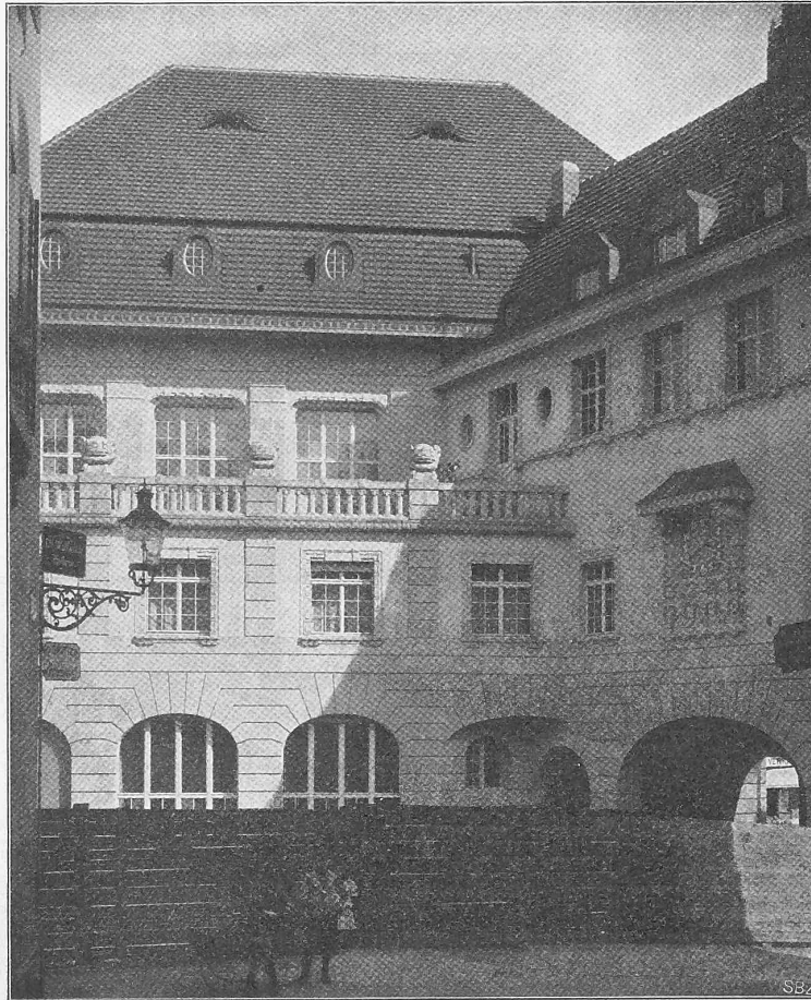
Abb. 7. Rückfassaden des Gebäudes nach dem Börsenplätzli.
