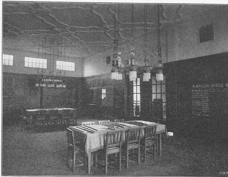
Abb. 10. Vorzimmer des Börsensaales.
