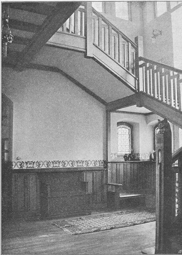
Fig. 31. Le hall de la «Savagère». Architectes MM. Monod & Laverrière, Lausanne.
