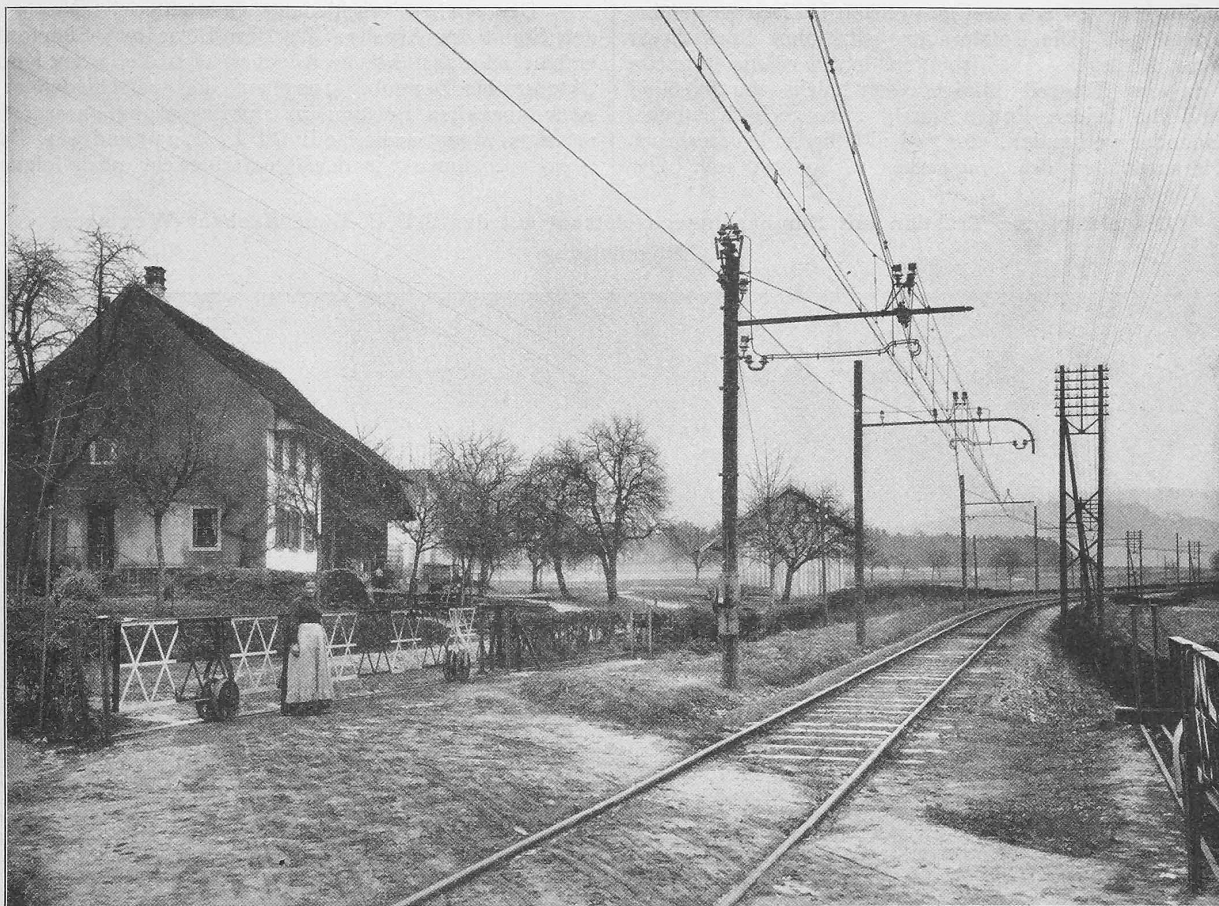
Abb. 33. Wegübergang bei Kempfhof. Streckenschalter mit der Schranke automatisch gekuppelt.
