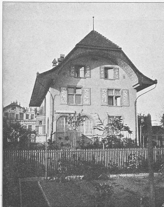
Fig. 10. Fassade latérale de la villa Jäger. Architectes MM. Schmid et Rosset, Lausanne et Veytaux.
