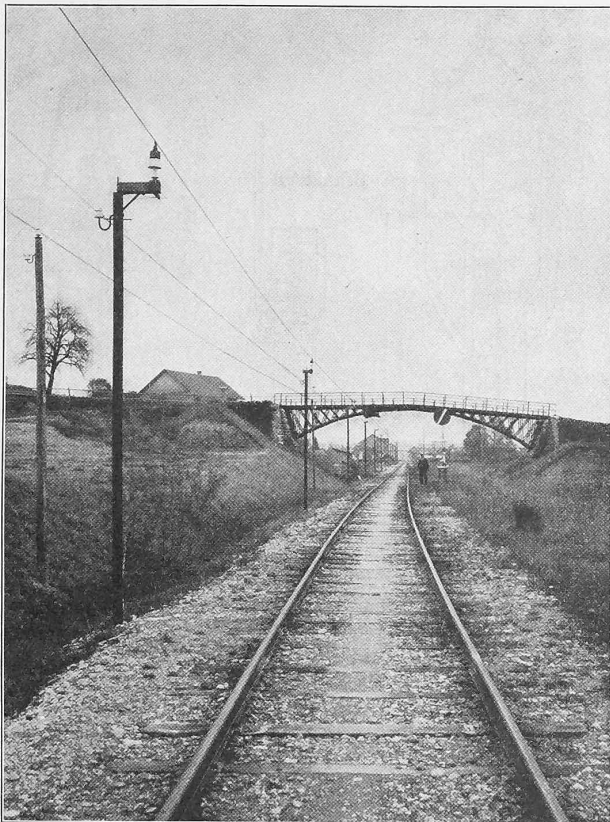
Abb. 14. Unterfahrung einer Wegbrücke bei Seebach.
