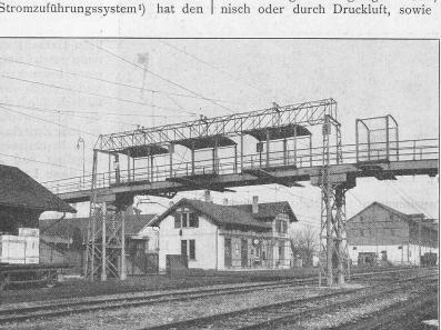
Abb. 11. Leitungsanordnung an der Passerelle im Bahnhof Seebach.
