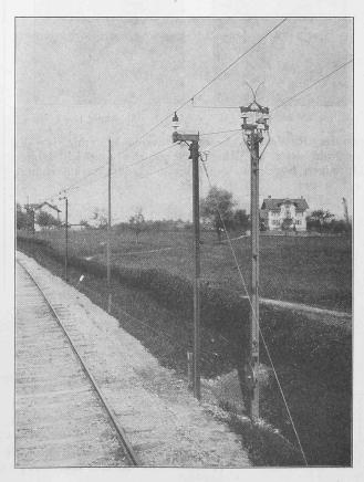
Abb. 22. Endabspannung einer Fahrleitungssektion; Hörnerschalter.
