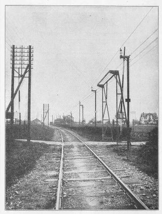
Abb, 18. Durch Eisenkonstruktion gesicherter Wegübergang.
