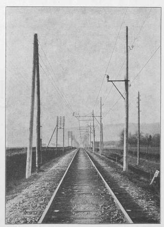
Abb. 26. Ende der Rutenleitung, Beginn der Bügelleitung.
