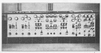
Abb. 8. Schalttafel der Umformerstation.
