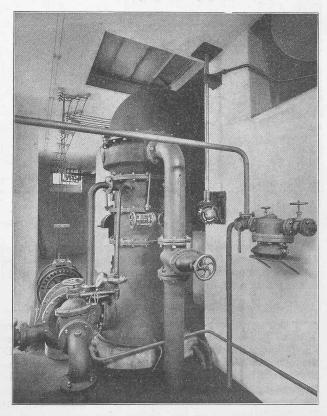
Abb. 4. Kondensationanlage für die Dampfturbine Oerlikon der Kraftzentrale.
