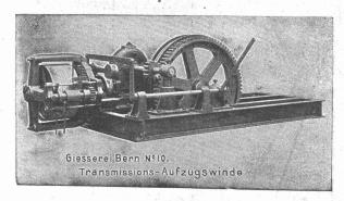
Hebezeuge jeder Art als Laufkräne, und feste oder fahrbare Drehkräne für Hand- und speziel elektrischen Betrieb; Aufzüge für hydraulischen, elektrischen und Transmissionsbetrieb.
