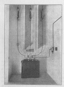
Abb. 56. Messtransformator für die abgehende 50000 Volt-Linie.
