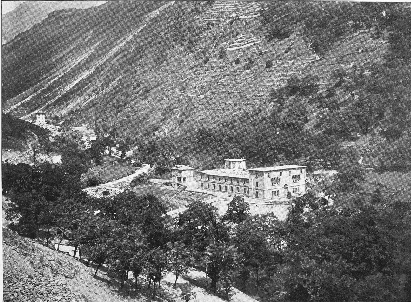
Die Kraftwerke Brusio und die Kraftübertragung nach der Lombardei.
