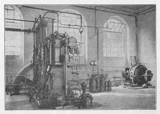
Abb. 4. Dreizylinder Dieselmotor von 120  $PS_{\varepsilon}$ , n=120, vom Schwungrad aus mittels Riemen eine Dynamo antreibend. (Anlage bei H. & A. Dufaux s. a. in Genf.)
