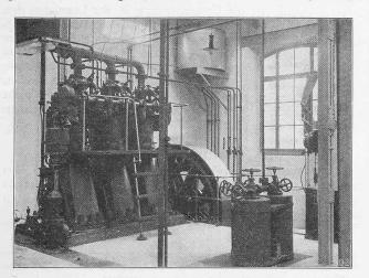
Abb. 2. Dreizylinder-Dieselmotor von 120  $PS_{\ell}$ , n=214, direkt gekuppelt mit Dreiphasen-Wechselstrom-Dynamo der Masch.-Fabrik Oerlikon. (Anlage bei Ed. Dubied & Cie. in Couvet.)
