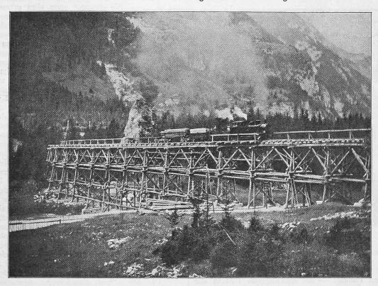
Abb. 12. Schlossweide-Viadukt, 147 m lang, 15,5 m hoch, R 65 und 60 m, Steigung 60% (60.
