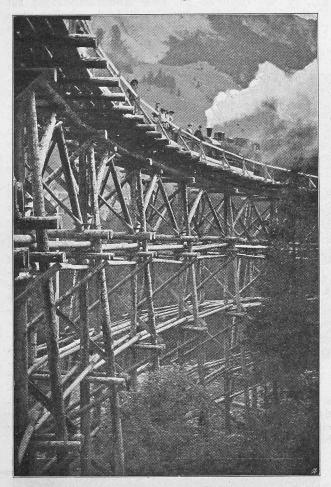
Abb. 15. Aegerten-Kehrviadukt von der innern Seite, 126 m lang, 18 bis 20 m hoch, R = 50 m, Steigung  $57^{\circ}/_{00}$ .
