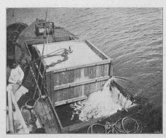
Abb. 17. Versenkung eines Ankerblockes.
