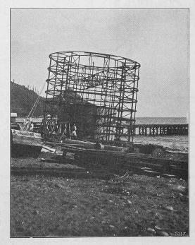
Abb. 13. Das eiserne Gerüst eines Senkkastens.
