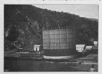
Abb. 14. Zum Transport fertig gestellter Senkkasten.
