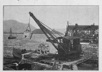
Abb. 16. Bau der Brückenpfeiler.
