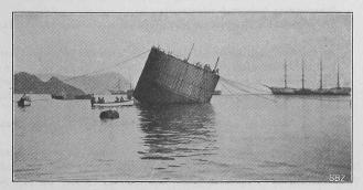
Abb, 15. Senkkasten an der Brückenbaustelle vor der Versenkung.
