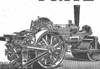
Ilefert kaufsund mietweise DAMPFSTRASSENWALZEN, Patent Aveling & Porter, und mietweise DAMPFSTRASSENWALZEN, mit oder ohne mechanischem Strassenaufbrecher; in Gebrauch bei einer grössern Anzahl schweiz. Behörden. Strassenlokomotiven zur Beförderung leichter und schwerer Lasten.
