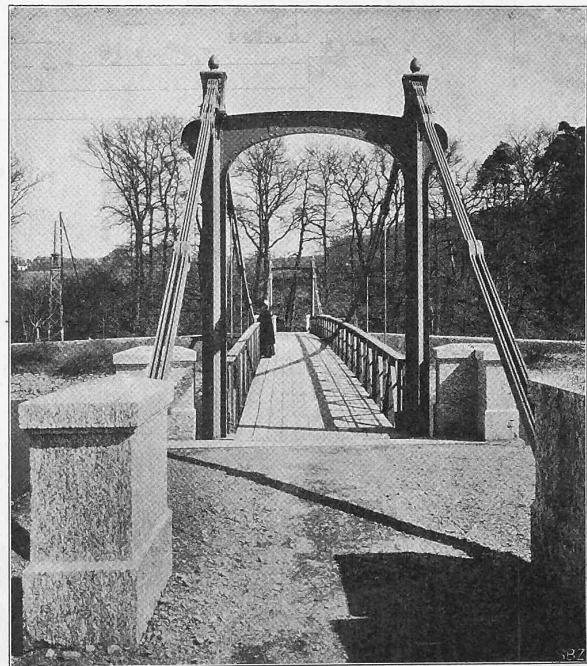
Abb. 2. Ansicht des Portals am linken Aareufer.
