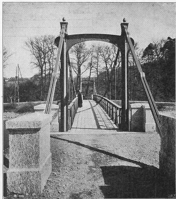
Abb. 2. Ansicht des Portals am linken Aareufer.
