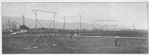
Abb. 28. Profil für den linksseitigen Damm des Diepoldsauer Durchstichs bei Hm 19 + 50, mit Brückenrampe.
