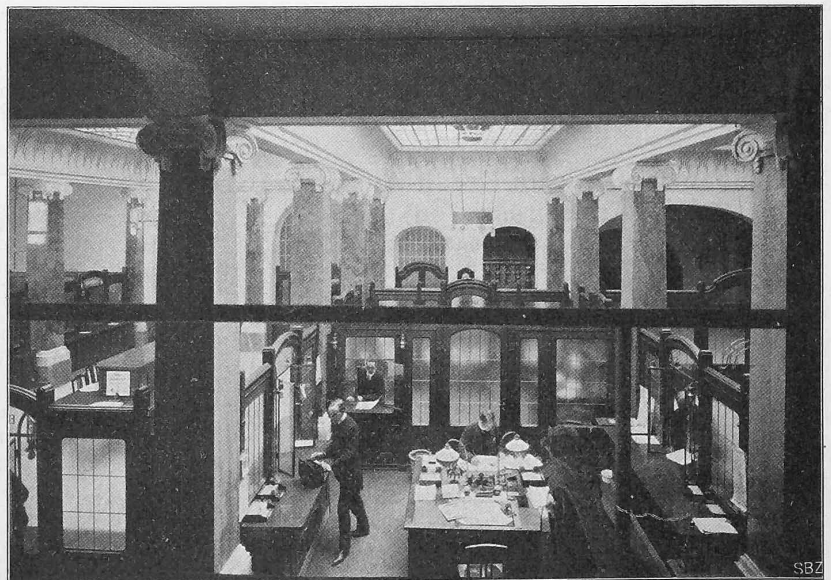
Abb. 13. Ueberblick über die Kassenträume vom Podest der Diensttreppe aus.
