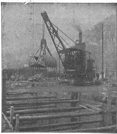
**Zweiketten-Greifbagger****Einketten - Selbst-Greifer (D. R. P.)**
