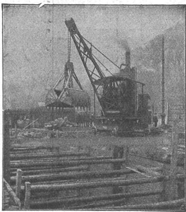
**Zweiketten-Greifbagger****Einketten - Selbst-Greifer (D. R. P.)**
