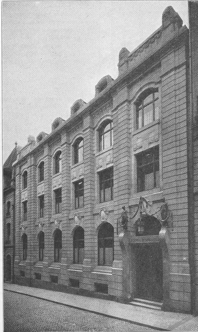
Abb. 10. Ansicht der Hauptfassade in der Freienstrasse.
