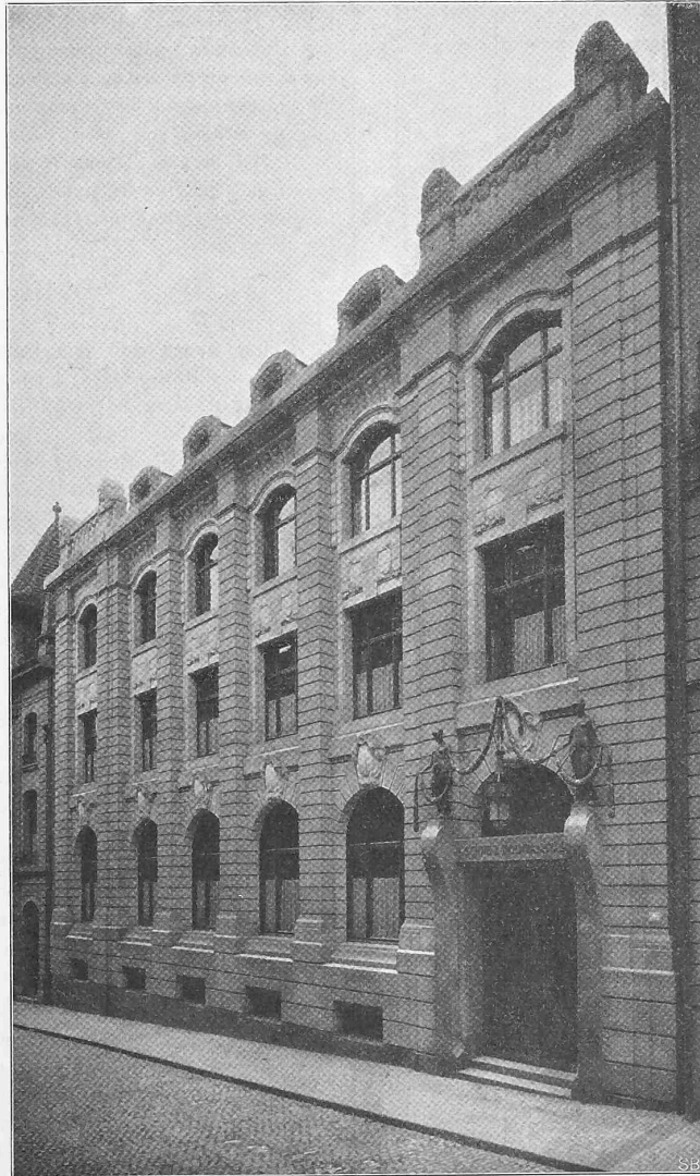
Abb. 10. Ansicht der Hauptfassade in der Freienstrasse.
