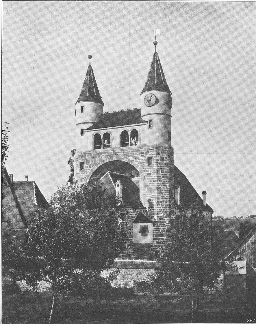
Abb. 6. Ansicht der Turm- und Chorphartie der Kirche von Norden.
