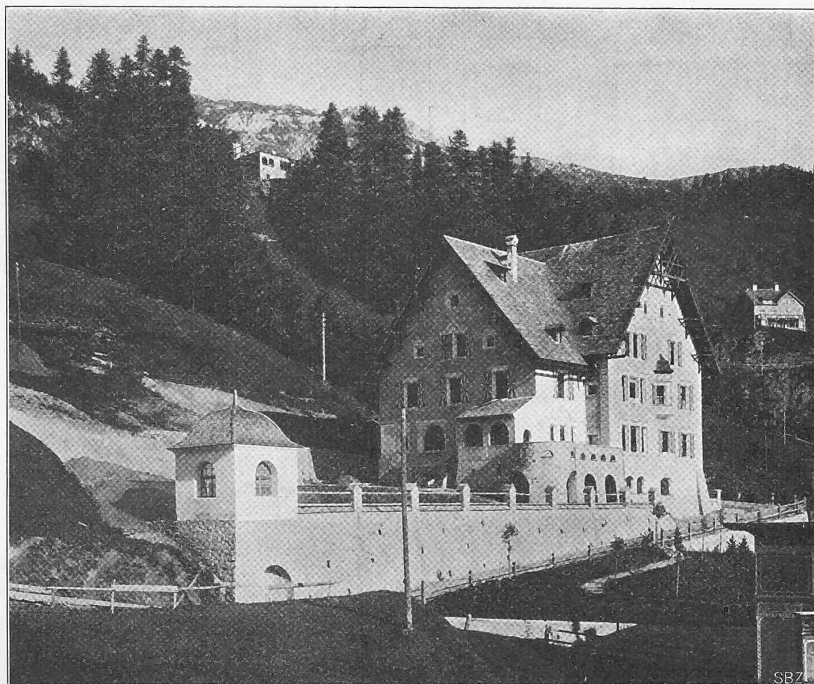
Abf. 1. Ansicht des Hauses von Südwest mit der Fassade gegen die Kantonsstrasse.
