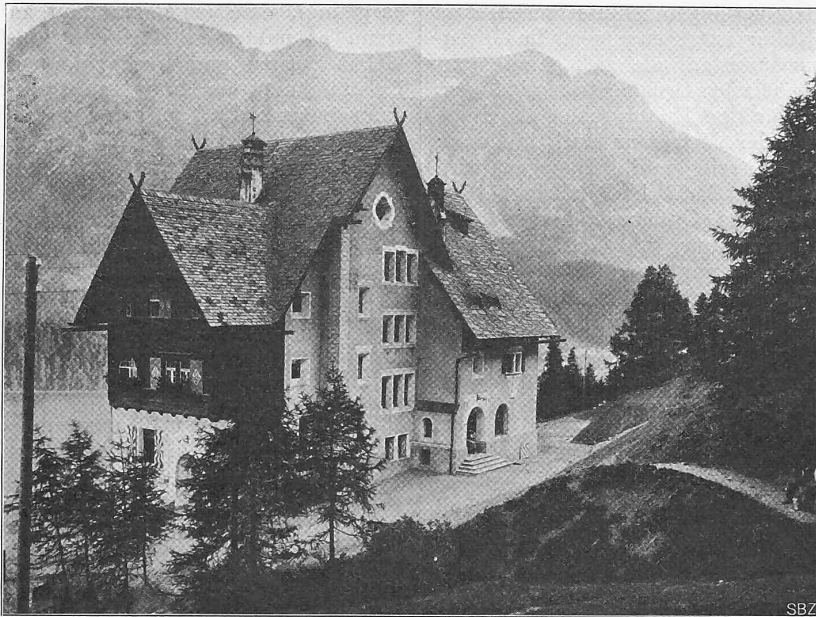
Abb. 7. Ansicht der Rückfassade des Hauses gegen den Berg.
