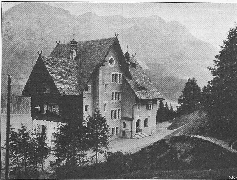
Abb. 7. Ansicht der Rückfassade des Hauses gegen den Berg.
