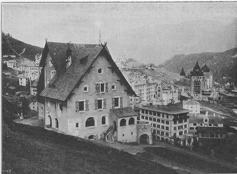
Abb. 8. Ansicht der Westfassade mit Blick nach St. Moritz-Dorf.
