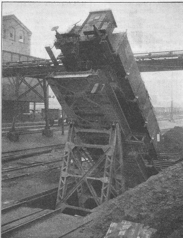
Wagenkipper der Maschinenfabrik Augsburg-Nürnberg.
