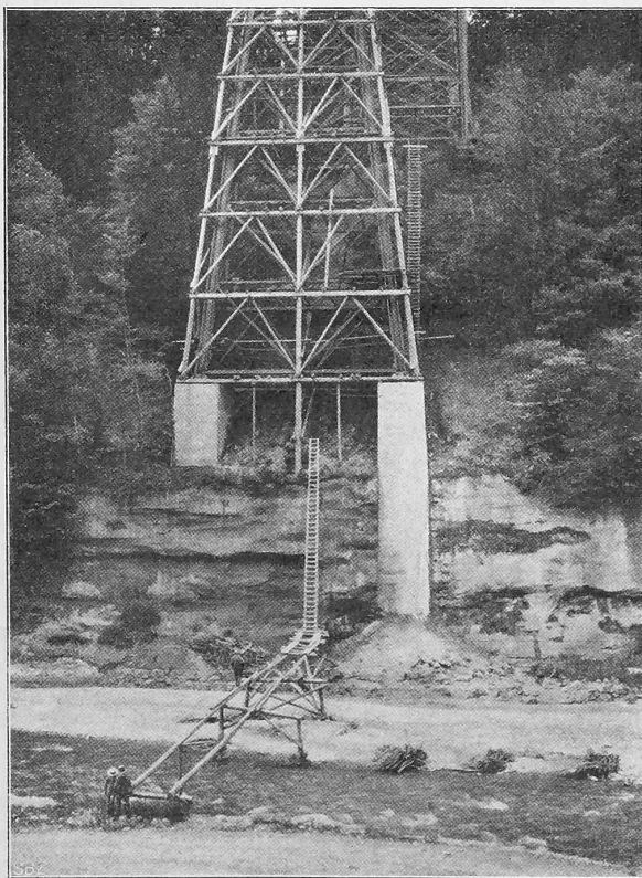
Abb. 10. Rechtsseitiges Pfeilerfundament während des Baues.
