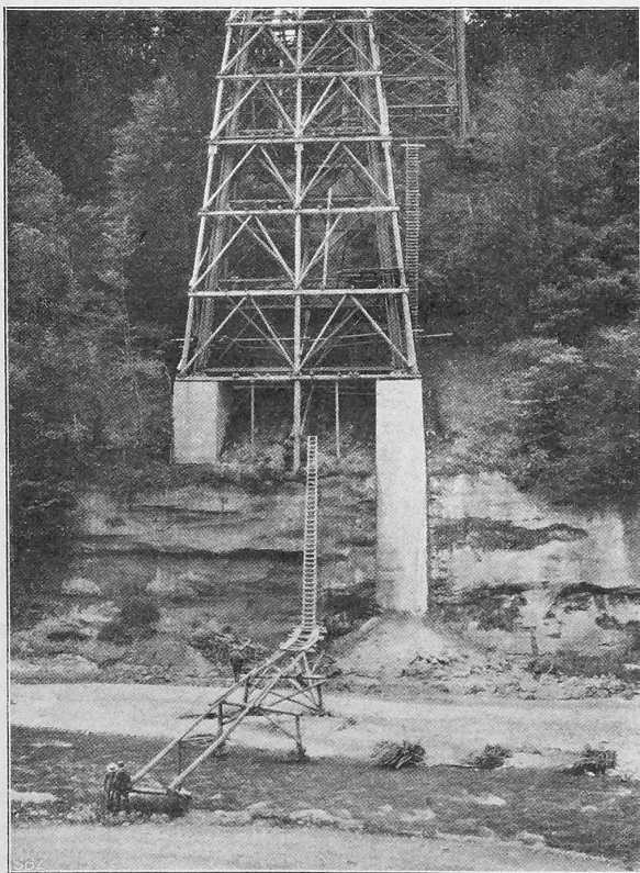
Abb. 10. Rechtsseitiges Pfeilerfundament während des Baues.
