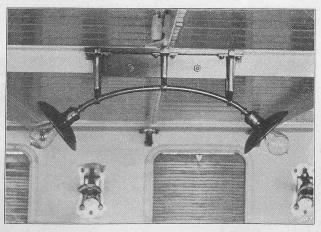
Abb. 9. Deckenbeleuchtung in der Kajüte I. Klasse des Dampfboots «Rhein».
