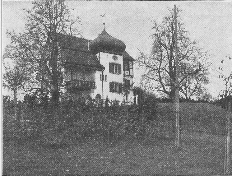
Abb. 5. Ansicht der Nordfassade.
