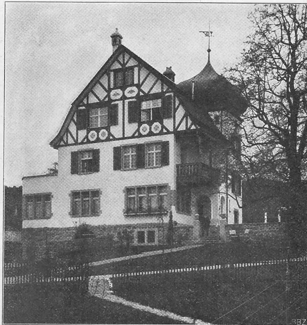
Abb. 1. Ansicht des Landhauses «Grieg» bei St. Gallen.
