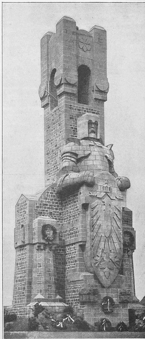
Abb. 7. Bismarckdenkmal in Bayenthal bei Köln (1903). Architekt: Arnold Hartmann. — Aus Basaltlava und Grauwacke, 30 m hoch, oben mit einer schmiedeeisernen, zur Entzündung von Petroleum bestimmten Schale.
