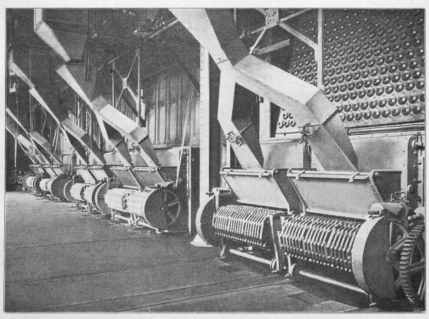
Abb. 45. Frontansicht der Wasserröhrenkessel System Dürr, mit Kettenrostfeuerung.
