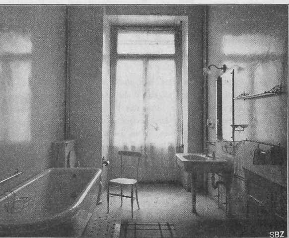
Abb. 17. Das Badezimmer eines Appartements.
