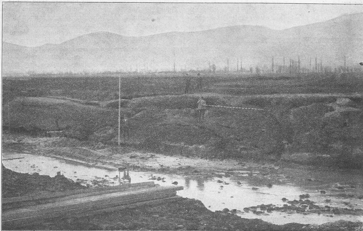
Abb. 11. Linksseitige Rutschung am Rheintalischen Binnenkanal bei Hm 80 + 95 bis Hm 81 + 95.
