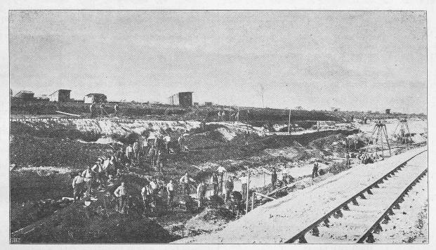
Abb. 12. Linksseitige Rutschung am Rheintalischen Binnenkanal bei Montlingen Hm 136 bis 138.
