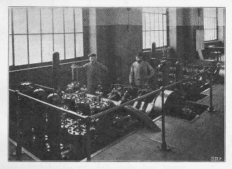
Abb. 37. Ansicht der Hochdruckpumpen für die Oeldruckanlage. Gebaut von Ingenieur A. Schmid, Maschinenfabrik in Zürich.
