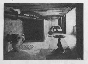
Abb. 40. Oelrückleitung und Reservoir.
