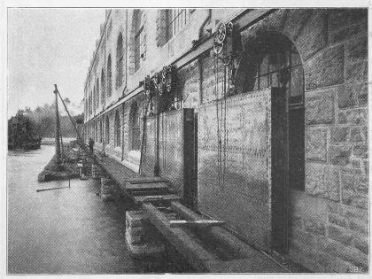
Abb. 43. Abschlusstore der Turbinenkammern.
