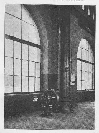
Abb. 41. Ansicht des Pressöl-Akkumulators.
