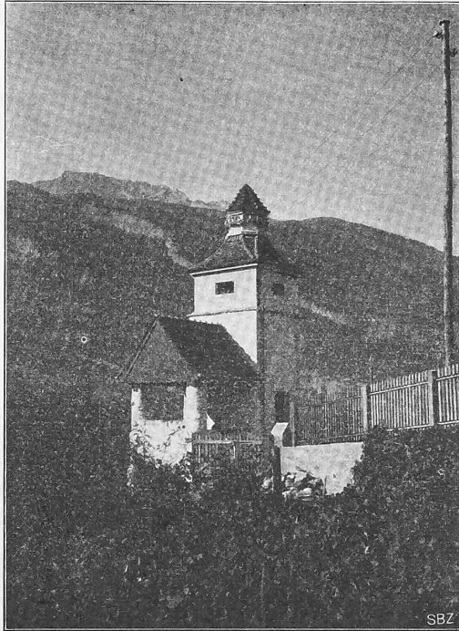
Abb. 1. Transformatorhäuschen ausserhalb der Stadt.
