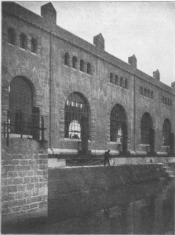
Abb. 22. Ansicht des Einlaufrechens zu den Turbinenkammern.
