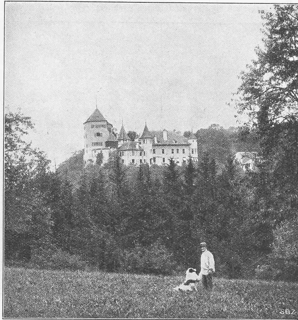
Abb. 4. Ansicht der wiederhergestellten Ostfassade.
