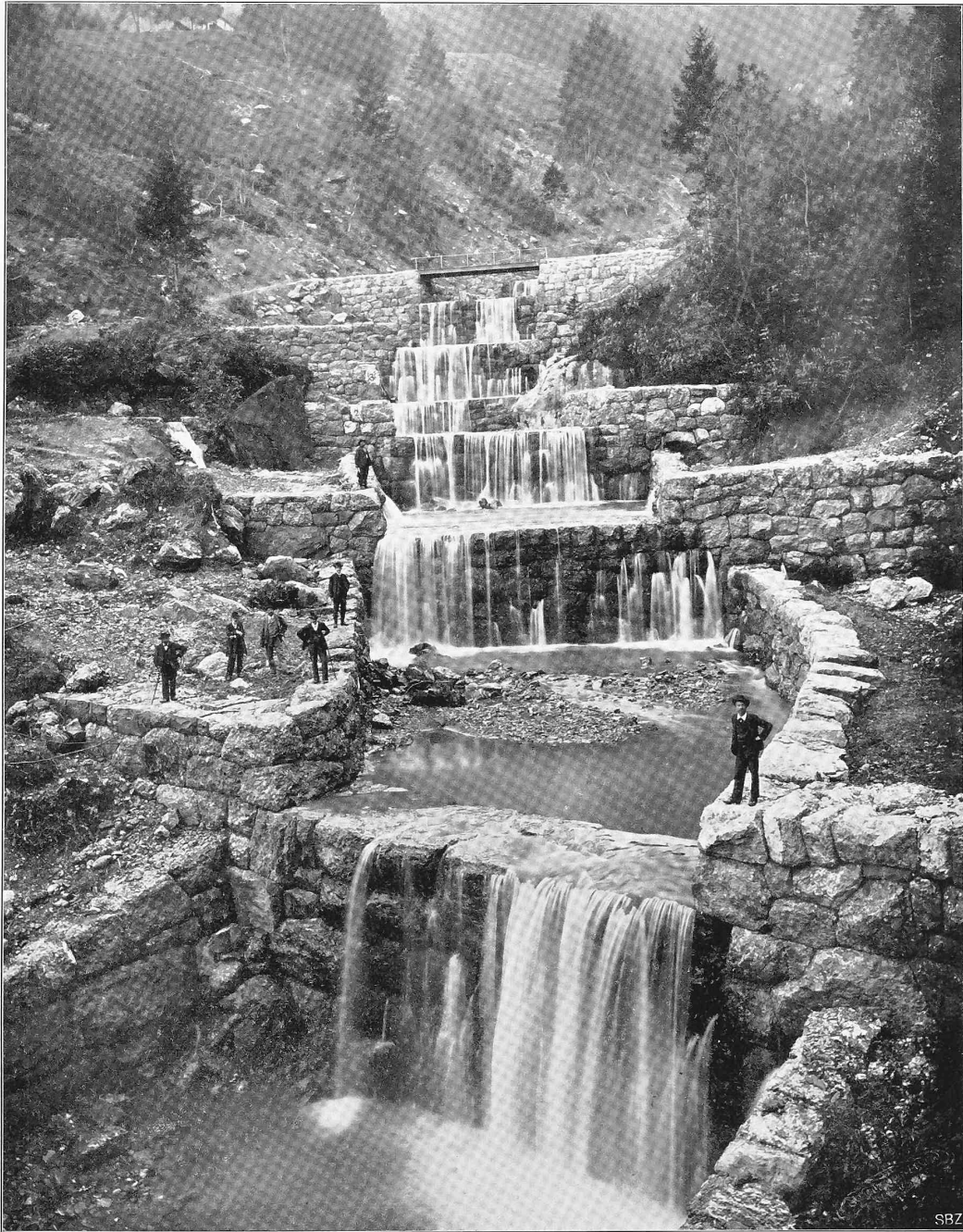
Verbauungen am Flibach bei Weesen.
