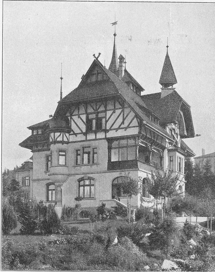
Abb. 6. Villa «Sonnhalde» in Zürich V. — Architekt Jacques Gros in Zürich.
