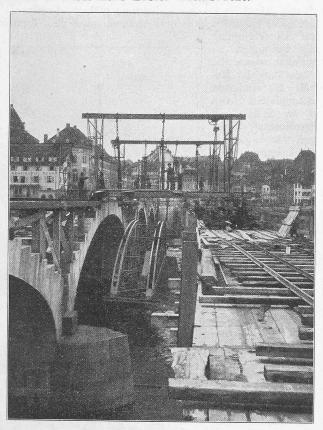
Abb. 33. Transport der Lehrgerüste von der Kleinbasler nach der Grossbasler Seite. — 13. Måi 1905.
