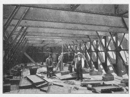
Abb. 26. Das Innere eines Caissons während der Montage.
