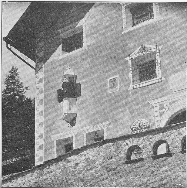
Abb. 5. Detail der Hauptfassade.
