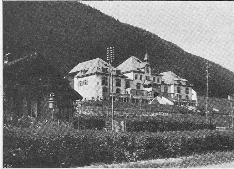
Abb. 1. Ansicht des Gebäudes von Südwesten.
