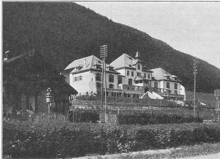
Abb. 1. Ansicht des Gebäudes von Südwesten.
