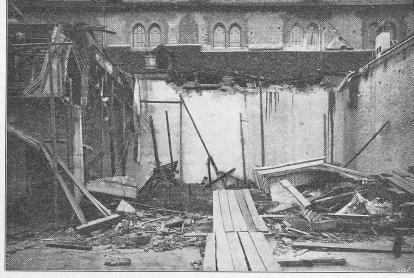
Abb. 3. Gesamtansicht des eingestürzten Gebäudeteiles.
