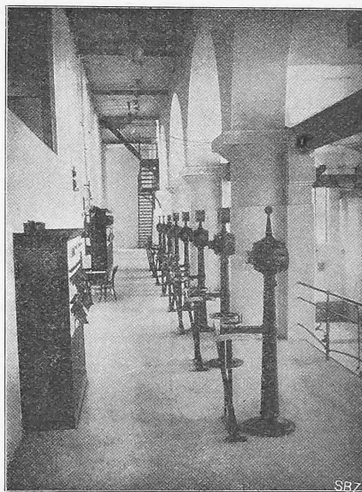
Abb. 61. Die Schaltbühne im ersten Stockwerk des Kraftwerkes Obermatt mit den Apparatsäulen.
