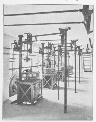
Abb. 64. Rheostaten für die Erregerstromkreise.
