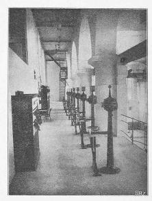
Abb. 61. Die Schaltbühne im ersten Stockwerk des Kraftwerkes Obermatt mit den Apparatensäulen.
