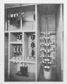
Ahb. 62. Schaltfeld eines 2000 P. S.-Generators (links: Ausschalter; siehe Abb. 56, S. 83) (rechts: Umschalter; siehe Abb. 57, S. 83).
