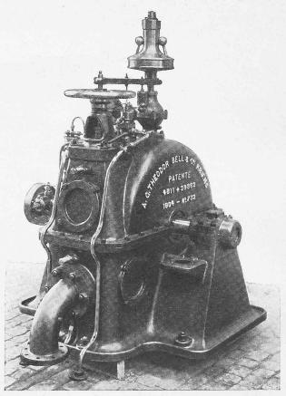
Abb. 51. Ansicht der 175 P. S. - Erreger-Turbine.
