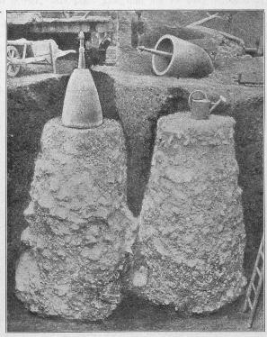
Abb. 20. Zwei ausgegrabene Fundationskörper.
