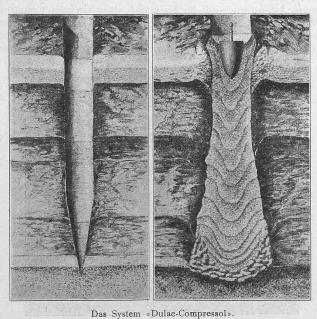
Abb. 15. Die durch die Ramme Abb. 16. Die mit eingestampftem hergestellte Höhlung.
