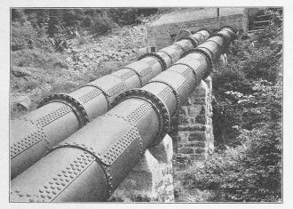
Abb. 30. Druckleitung zwischen den beiden untern Fixpunkten (SI-SII).
