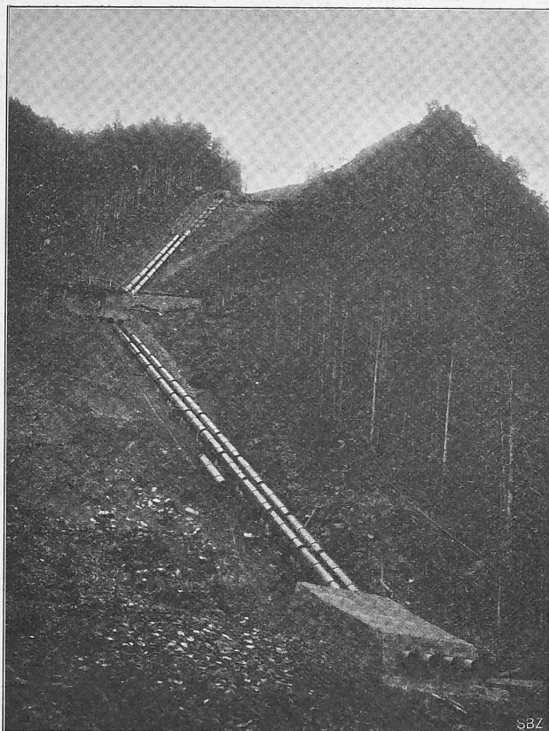
Abb. 21. Ansicht der Druckleitung zwischen den Fixpunkten SII und SIV.
