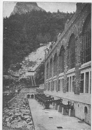
Abb. 22. Druckleitung und Verteilleitungen beim Kraftwerk.
