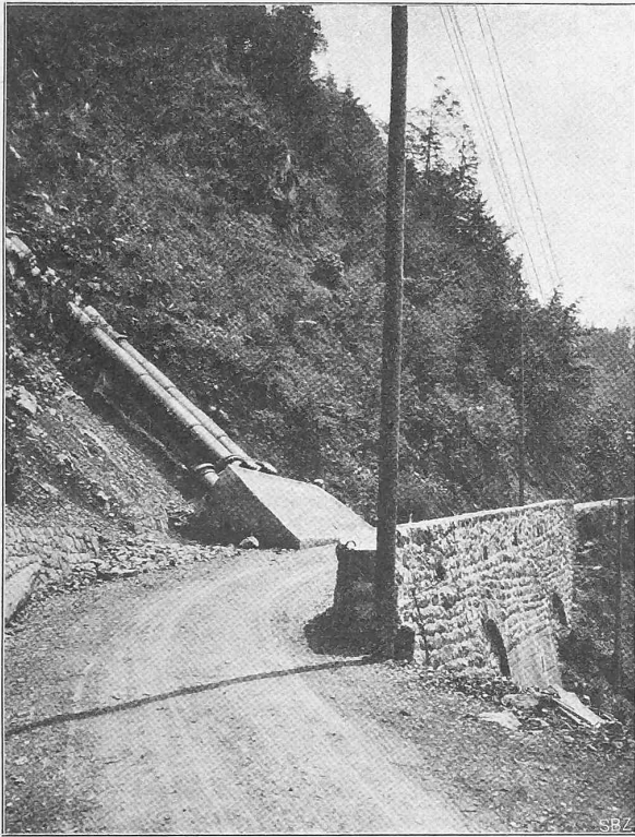
Abb. 23. Die Druckleitung bei S III und die Engelberger Strasse.
