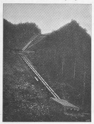
Abb. 21. Ansicht der Druckleitung zwischen den Fixpunkten SII und SIV.
